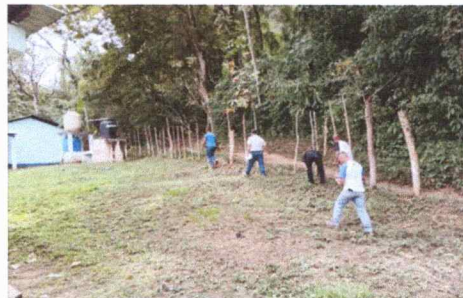
Foto 4: cerco perimetral en mal estado.
