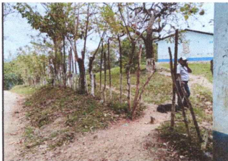
Foto 1: se observa el deterioro del cerco perimetral.
